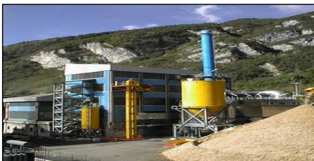
Una centrale elettrica a biomassa
